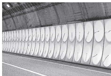
国道 8 号線城山トンネル（富山県朝日町）
