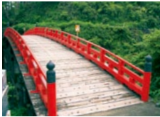
布橋 Nunobashi Bridge
